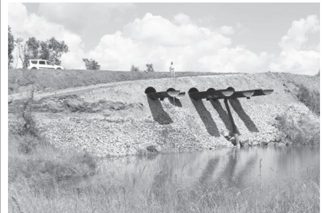
реплено и расширено до 10 метров тело плотины (до начала ремонтных работ ширина ГТС составляла 3 м). По словам специалистов, решена главная задача - безопасность данного гидротехнического сооружения. Теперь во время весеннего половодья, а также в период пуска воды по Саратовской оросительной системе не будет допущено размытия ГТС.
